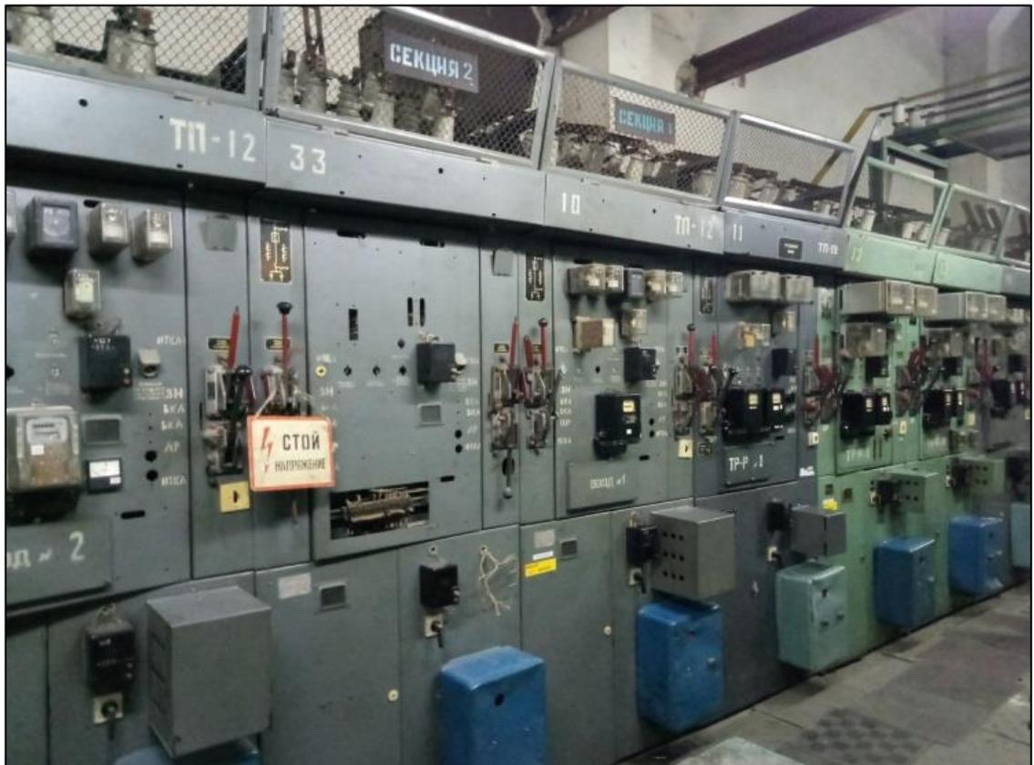
Во время проведения работ на секции 1 (где отсутствовало напряжение) электромонтажник 1 самовольно расширил рабочее место и был поражён электрическим током в ячейке 32 секции 2, находящейся под напряжением.
